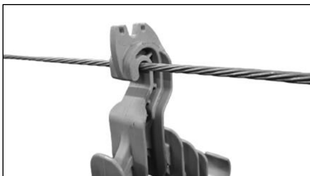
1) Posicione o espaçador no Cabo Mensageiro.
