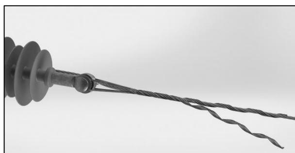
**4)** Partindo da marca colorida, faça a aplicação da segunda perna da Alça Preformada e finalize a aplicação.
